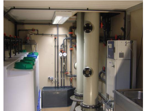
Abb. 6: Pilotversuch Ionenaustauscher am Burgfeyer Stollen (links: Draufsicht, rechts: Blick in den Container) (Quelle: Erftverband)
